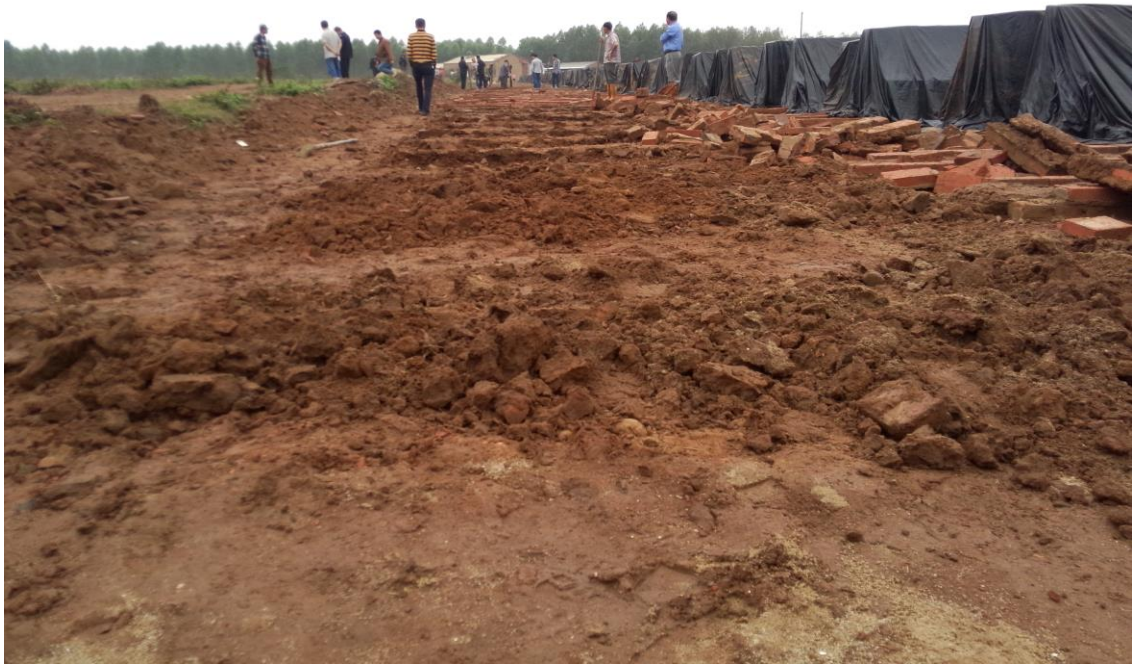
违建红砖晒场拆除现场
